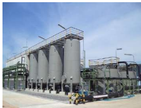
ภาพที่ 2.2-2 (19) ระบบบำบัดน้ำเสียส่วนกลาง แห่งที่ 3 ชนิด Membrane Bio-Reactor
