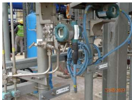
ภาพที่ 2.2-2 (68) อุปกรณ์วัดความดัน (Pressure Indicator)
