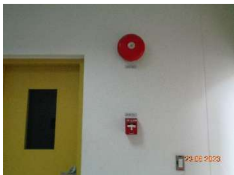
ภาพที่ 2.2-2 (51) ระบบแจ้งเหตุเพลิงไหม้ (Fire Alarm)
