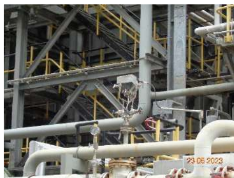
ภาพที่ 2.2-2 (70) อุปกรณ์วัดระดับ (Level Indicator)
