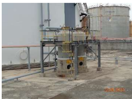
ภาพที่ 2.2-2 (16) ตัวดูดซับด้วยถ่าน ( Activated Carbon Canister) ที่บริเวณถังเก็บสารอินทรีย์
