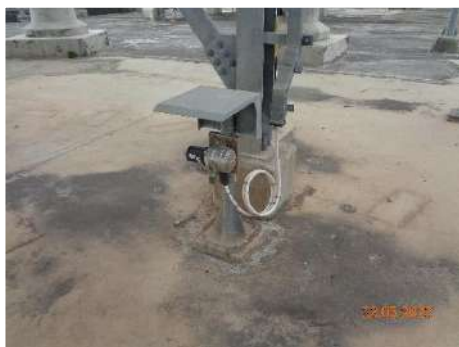
ภาพที่ 2.2-2 (69) อุปกรณ์วัดอุณหภูมิ (Temperature Indicator)
