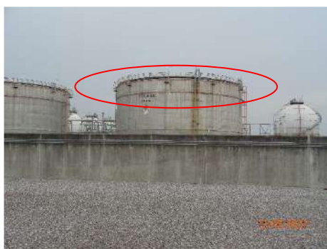
ภาพที่ 2.2-2 (47) ระบบฉีดโฟมดับเพลิง บริเวณถังเก็บ Flammable Liquid และ Combustible Liquid
