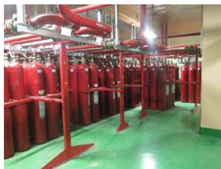
ภาพที่ 2.2-2 (48) ระบบดับเพลิงด้วยก๊าซ บริเวณที่เกี่ยวข้องกับอุปกรณ์ทางระบบไฟฟ้า สายไฟ และสถานีไฟฟ้าย่อย
