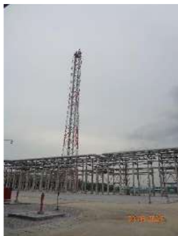
ภาพที่ 2.2-2 (12) หอเผาทั้งระดับเหนือพื้นดิน (Elevated Flare)
