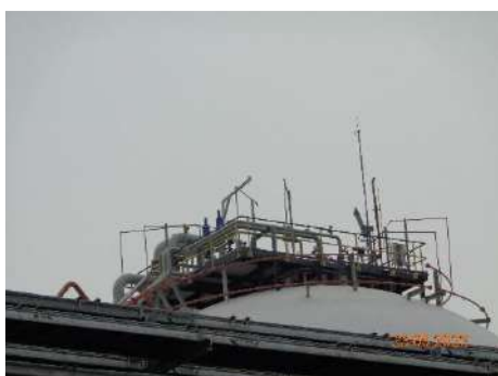
ภาพที่ 2.2-2 (71) Pressure Relief Valve ตั้งที่เก็บชนิดทรงกลม
