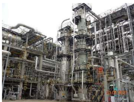
ภาพที่ 2.2-2 (10) Amine Scrubber บริเวณปล่อง TGTU Stack (73Z401)
