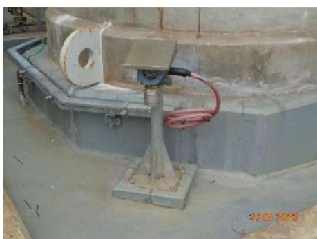
ภาพที่ 2.2-2 (55) อุปกรณ์ตรวจจับการรั่วไหลของก๊าซ
