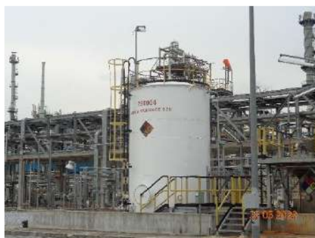
ภาพที่ 2.2-2 (65) กำแพงกันโดยรอบ บริเวณที่เก็บสำรองสารเคมี
