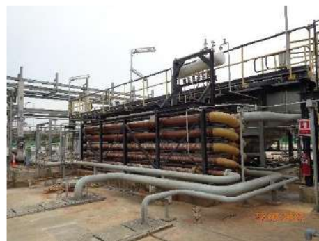
ภาพที่ 2.2-2 (23) ระบบบำบัดเบื้องต้นแบบแยกน้ำ และน้ำมันด้วยตัวกลางแบบแผ่นขนาน (CPI) และระบบบำบัดเบื้องต้นแบบใช้อากาศแยกน้ำ ออกจากน้ำมัน (IAF)
