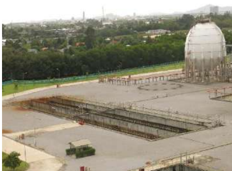
ภาพที่ 2.2-2 (26) ระบบบำบัดแบบ API (API Pond)
