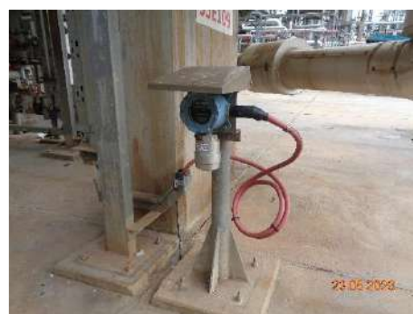
ภาพที่ 2.2-2 (72) Gas Detector บริเวณลานถัง
