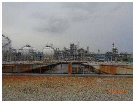
ภาพที่ 2.2-2 (25) บ่อรวบรวมน้ำฝน (Oily Collection Sump)
