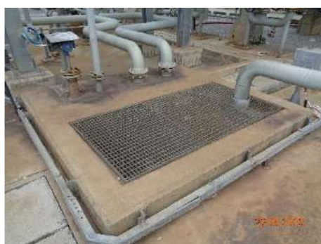
ภาพที่ 2.2-2 (20) บ่อรวบรวม (Blowdown Sump)
