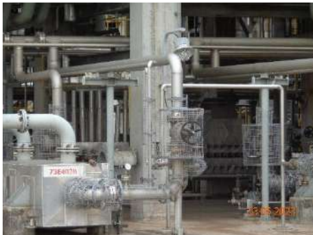
ภาพที่ 2.2-2 (76) ตะแกรงเหล็ก (Personal Protection)
