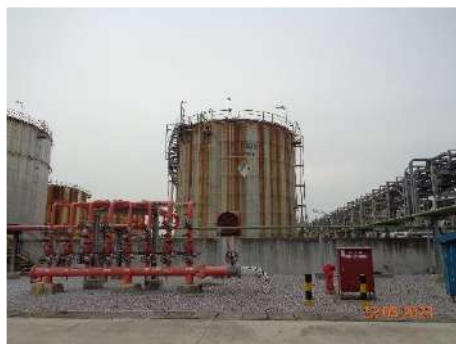
ภาพที่ 2.2-2 (31) ถังรวบรวมน้ำมัน (Slop Tank)
